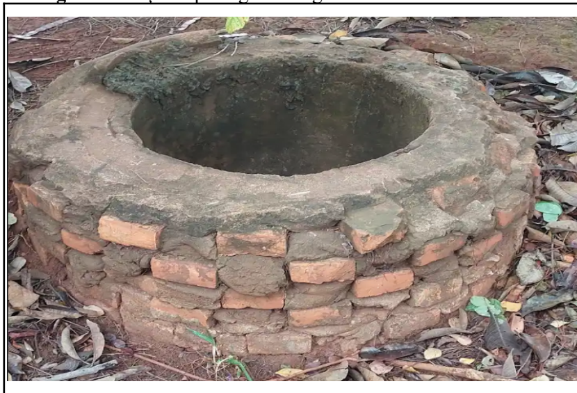
Figura 3: Poço de passagem de água subterrânea CEA Anhanduí
