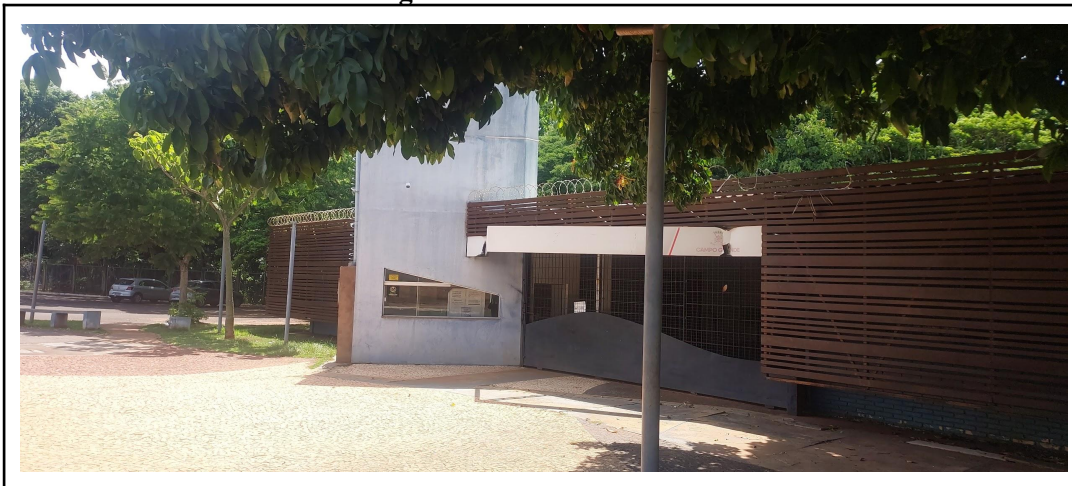
Figura 13: Fachada do CEA Imbirussu.
