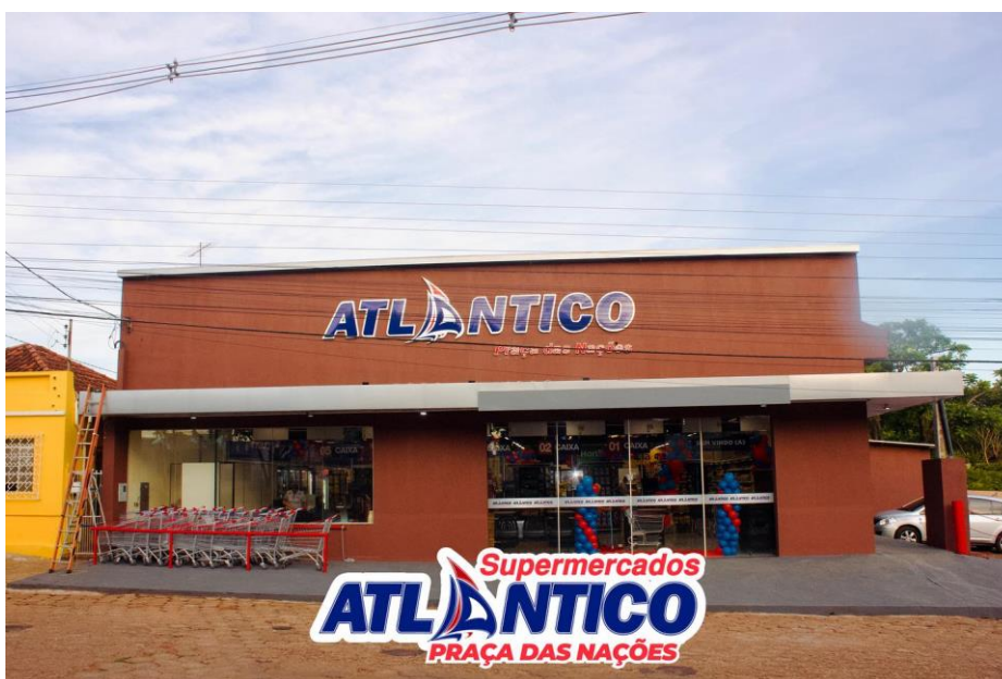
Figura 7 – Fachada principal do supermercado atlântico praça das nações em Anastácio, filial 4.
