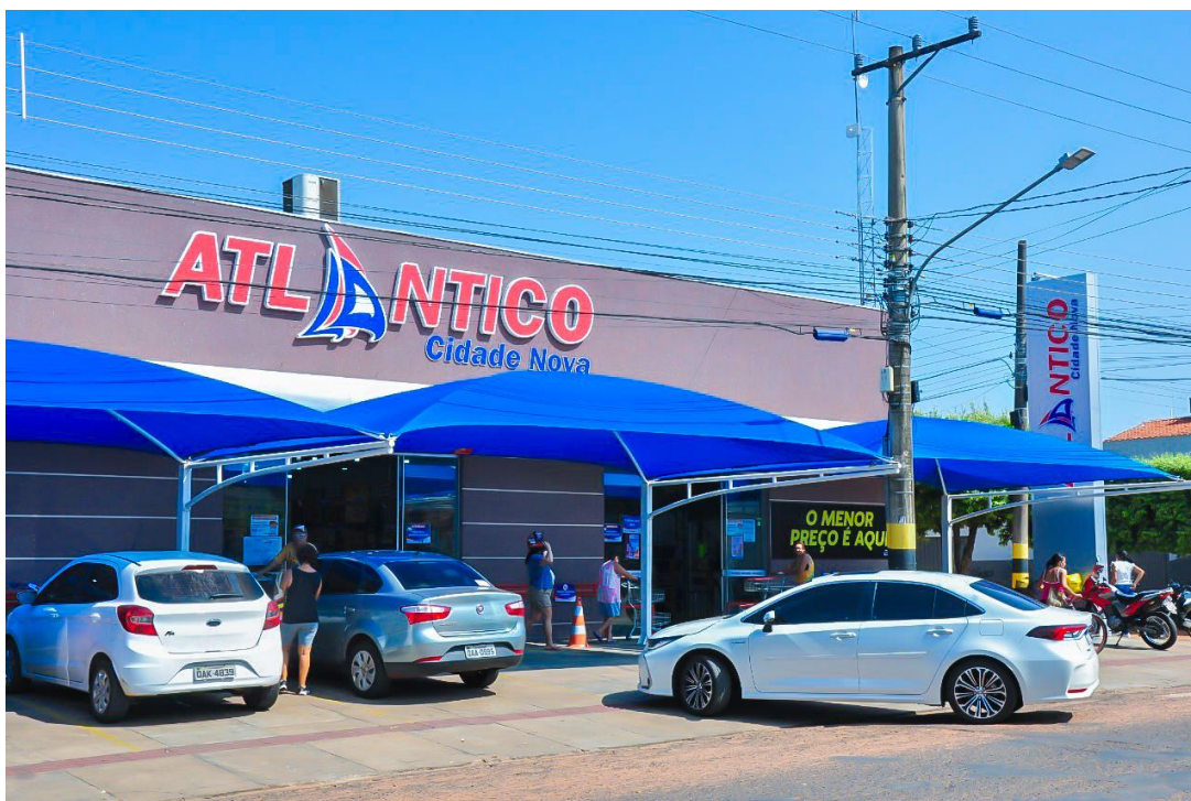
Figura 5 – Fachada principal do supermercado atlântico cidade nova, filial 2.
