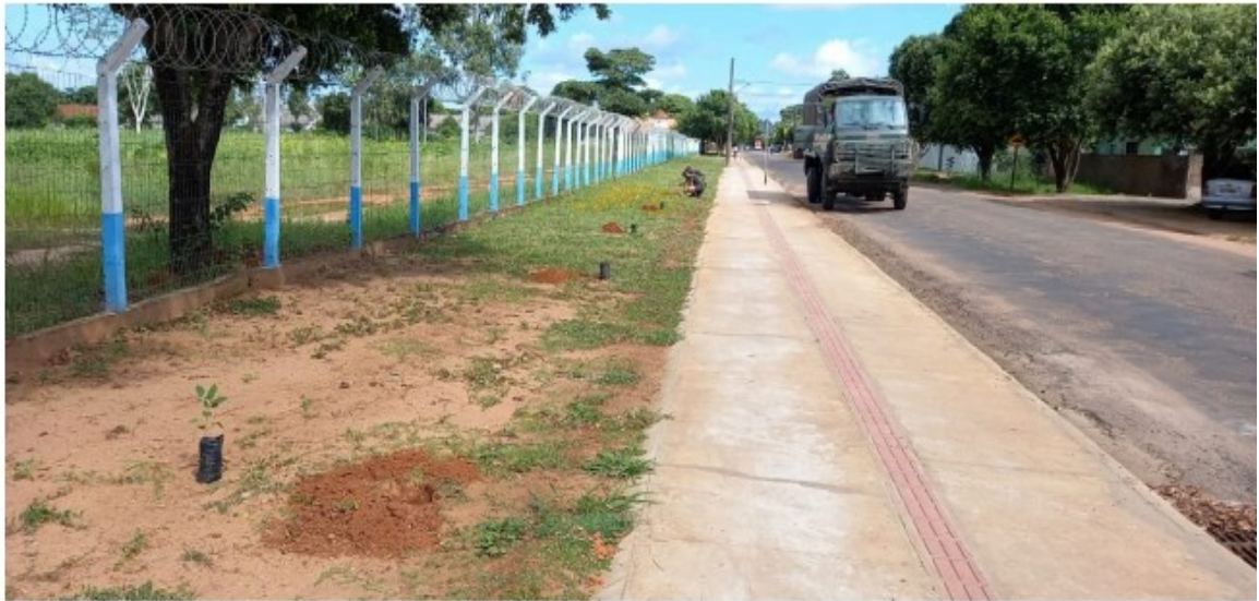
Figura 6: Abertura de covas e plantio de mudas Bauhinia forficata na Face Leste
