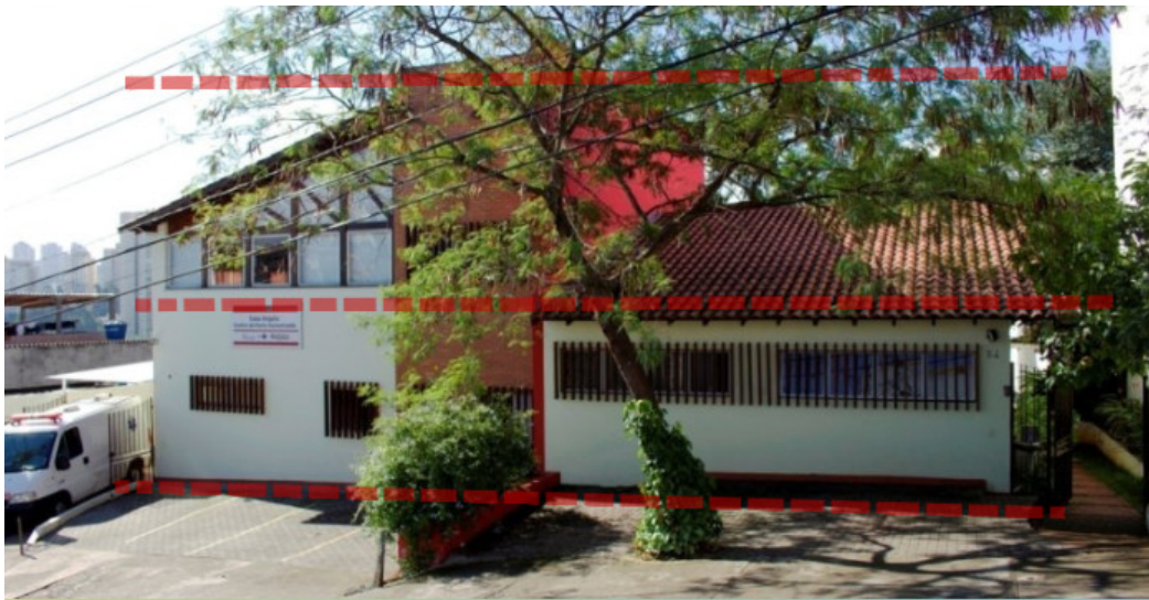
Figura 20 - Fachada Casa Angela com níveis de piso.
