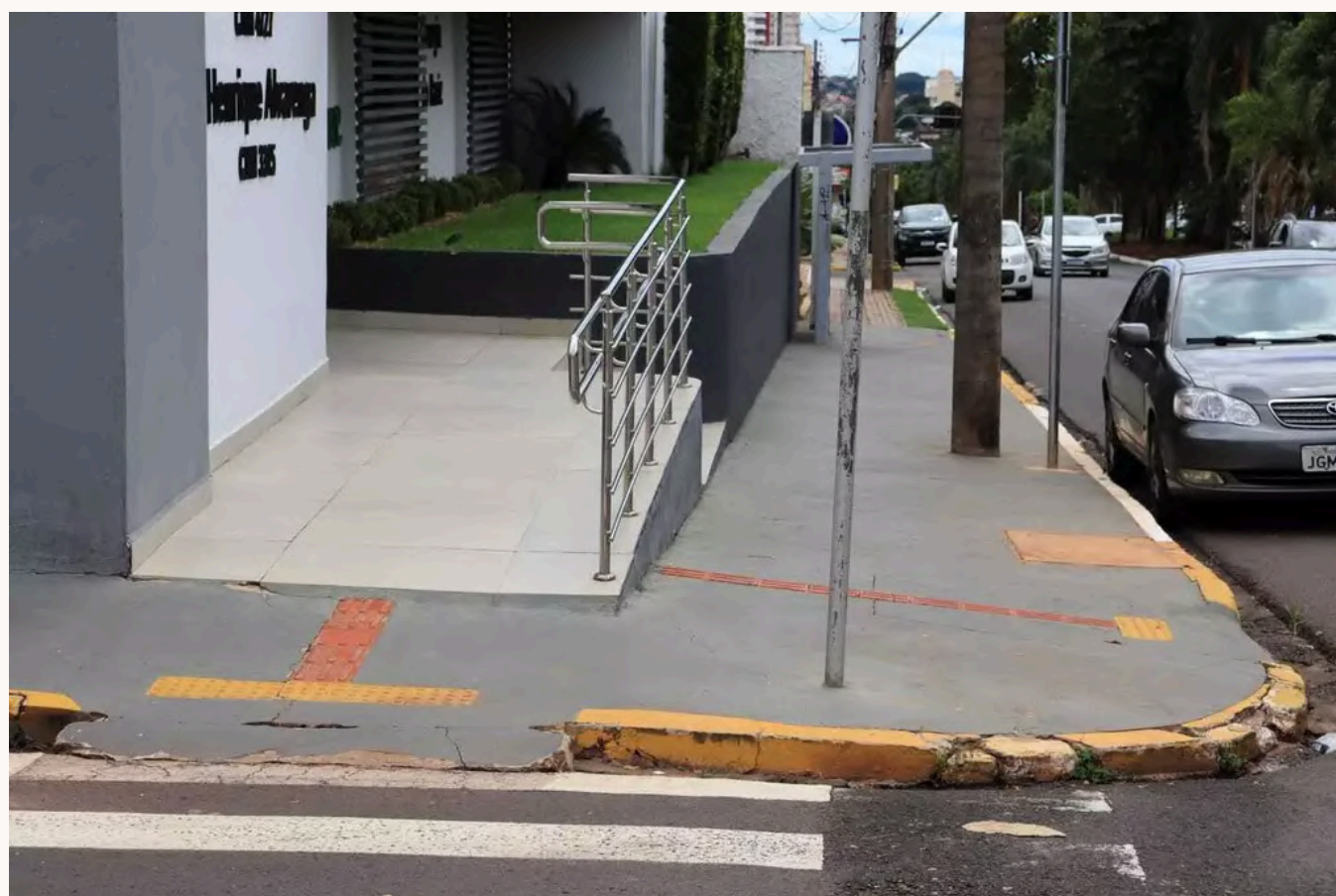
Figura 26: Piso tátil interrompido por rampa na Avenida Mato Grosso. Fonte: Campo Grande News, 2025.
