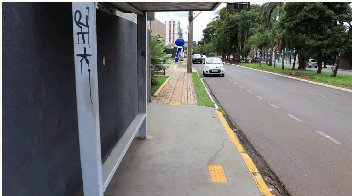
Figura 25: Calçada incompleta em trecho da Avenida Mato Grosso. Fonte: Campo Grande News, 2025.
