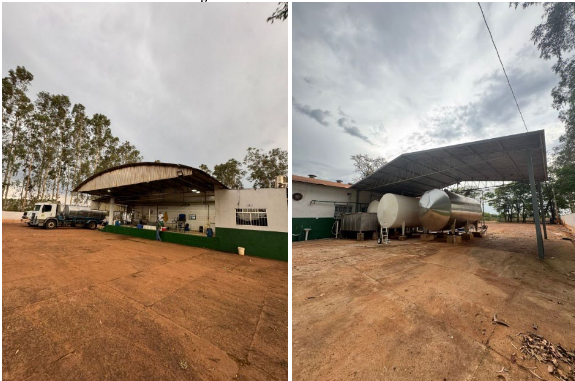
Figuras 01/02: área dos silos de leite.
