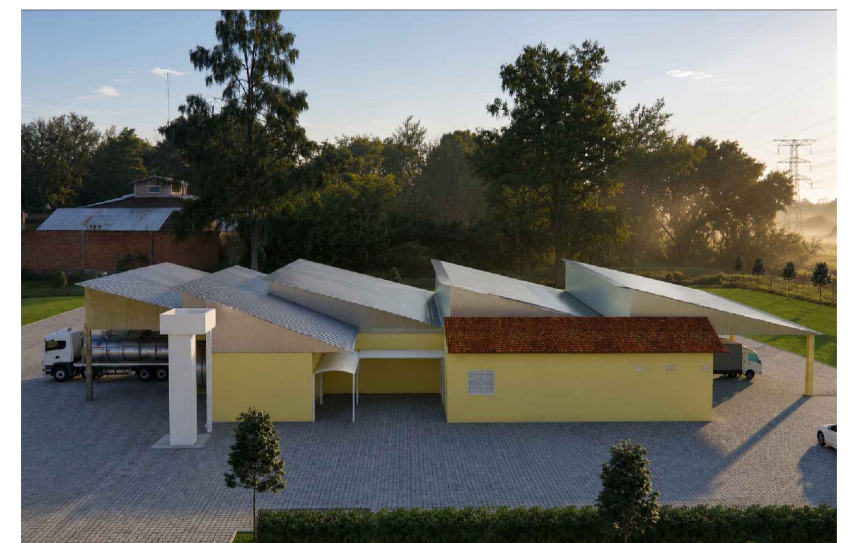
VISTA LATERAL DIREITA DO EDIFÍCIO
