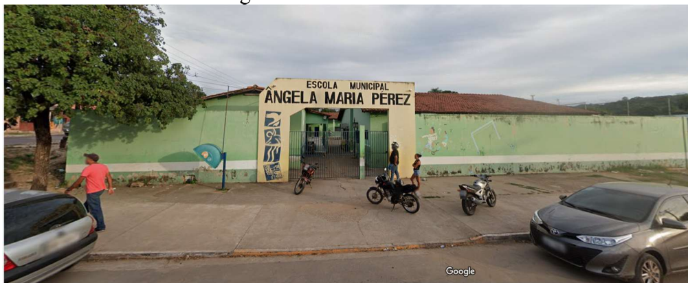
Figura 3 – Fachada da escola
