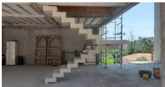
Imagem 02 – Exemplo de escada em balanço.
