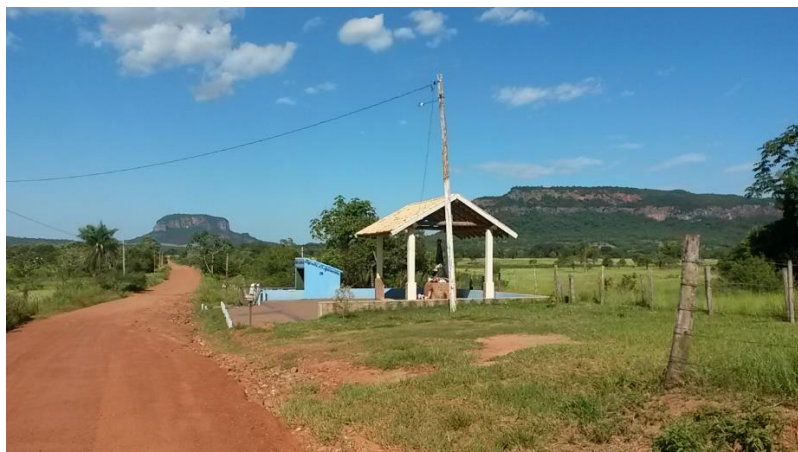
Figura 13 – Estrada de Terra Comunidade Furnas dos Baianos.
