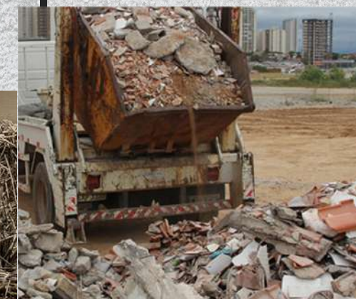
FIGURA 30 - CAÇAMBA COLETANDO RCC FONTE: RETIRADO DE A3P ECO
