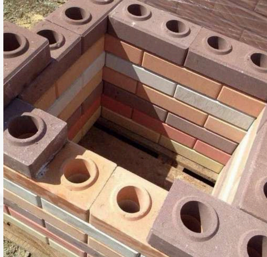
FIGURA 91 - BTC (BLOCO DE TERRA COMPRIMIDA) FONTE: RETIRADO DE PÓRTIS SOLUÇÕES
