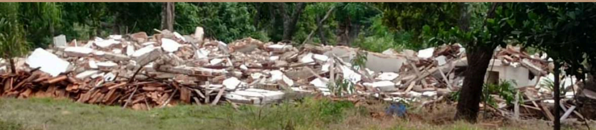
FIGURAS 46 E 47 - DESCARTE IRREGULAR DE RCC - R. JOÃO KUSSAREV, JARDIM VERANEIO FONTE: AUTORA, 2024
