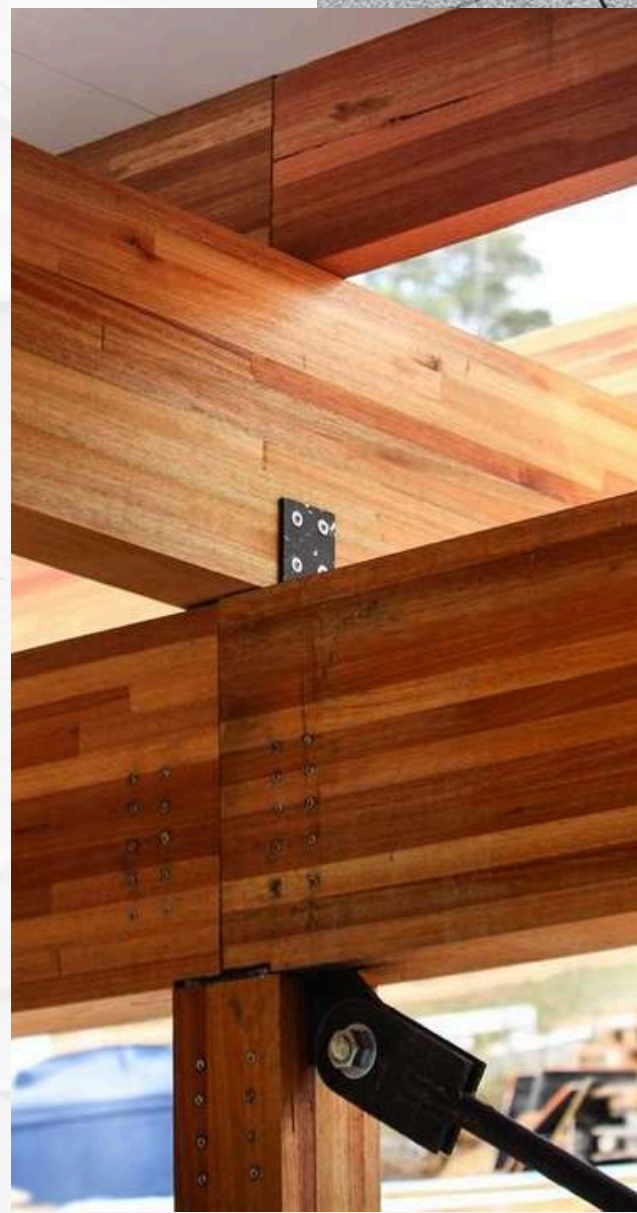
FIGURA 92 - ESTRUTURA EM MLC (MADEIRA LAMINADA COLADA) FONTE: RETIRADO DE CORNETTA ARQUITETURA
