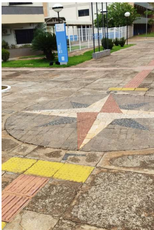
Figura 36 – Calçada na frente da reitoria da UFMS com interrupção no piso tátil. Descrição da figura: Calçada com piso tátil que é interrompido por uma obra de arte, representando uma bússola. Após a bússola, o piso tátil continua.
