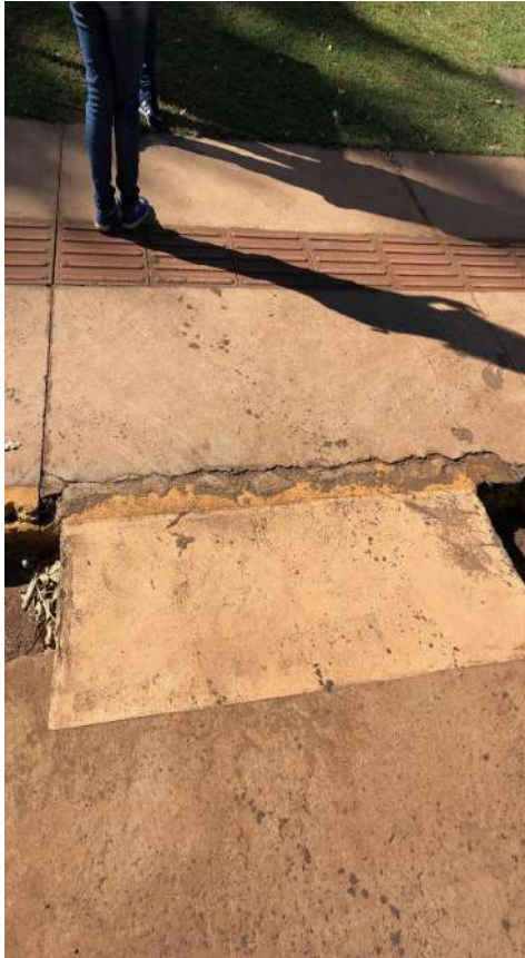
(a) Piso tátil sem a sinalização com o piso de alerta, registrado no ano de 2021.
