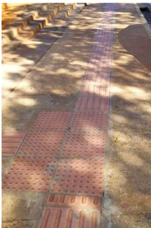
(a) Piso de alerta instalado no ponto de conversão para acesso à biblioteca.
