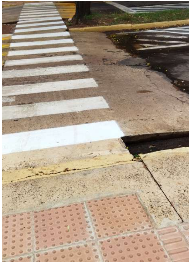
Figura 37 – Faixa elevada para travessia de pedestres sem a presença do piso tátil. Descrição da figura: Faixa elevada para travessia de pedestres sem a presença do piso tátil. Na extremidade do ponto de acesso à faixa há um desnível (degrau), sem nenhuma sinalização.
