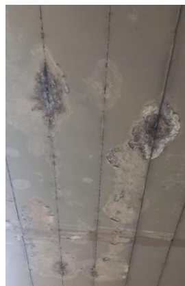
Figura 13 – Degradação do concreto na lateral do viaduto.
