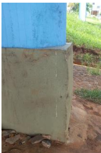
Figura 11 – Falha construtiva da recuperação na base do pilar. Fonte: Autora
