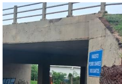
Figura 13 – Degradação do concreto na lateral do viaduto.
