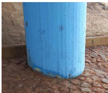
Figura 11 – Falha construtiva da recuperação na base do pilar. Fonte: Autora
