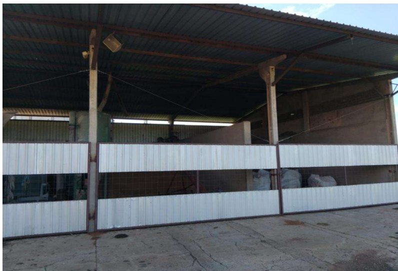
Figura 03 - Galpão de sementes, armazenamento.
