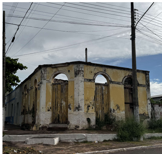
Figura 10 - Fachada da edificação Casarão
