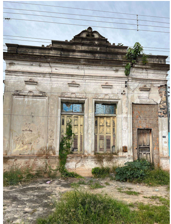
Edificação Leonor Corrêa Barraca
