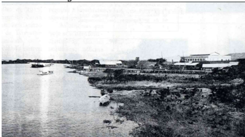
Figura 5- Porto do Arsenal de Ladário
