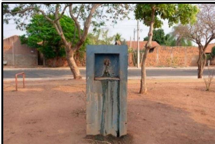
Bebedouro deteriorado, sem torneira e com vazamento de água.
