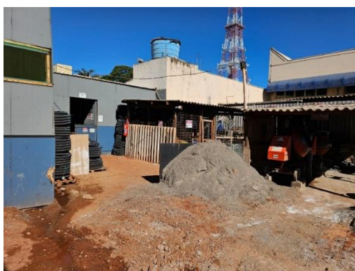
Figura 7 — Canteiro antes da implantação Lean.
