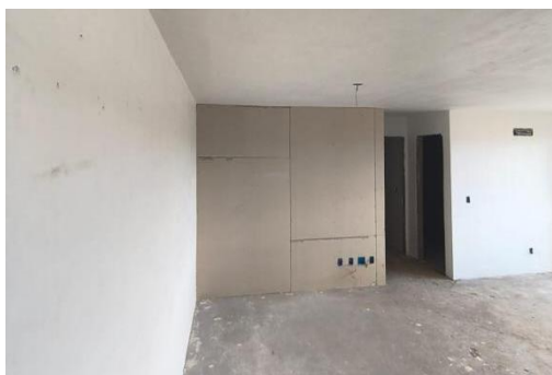
Figura 5 — Drywall finalizado T2.
