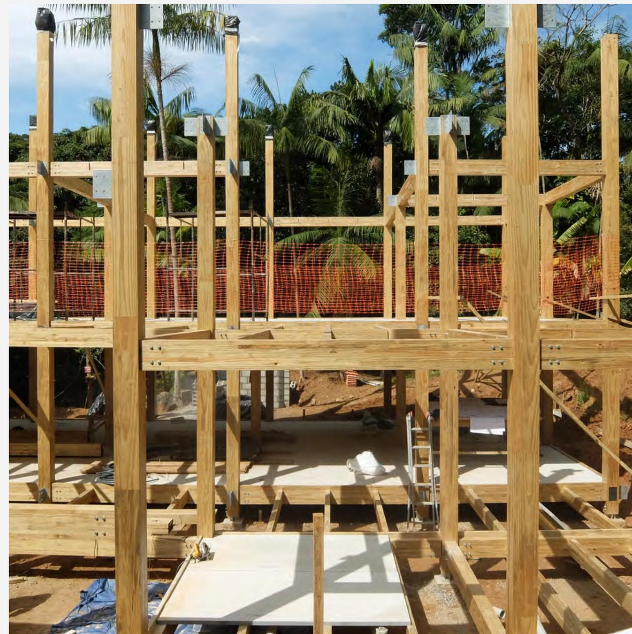
ILUSTRAÇÃO 46 - Etapa de montagem do sistema pilar-viga em MLC (ARCHDAILY, 2022).
