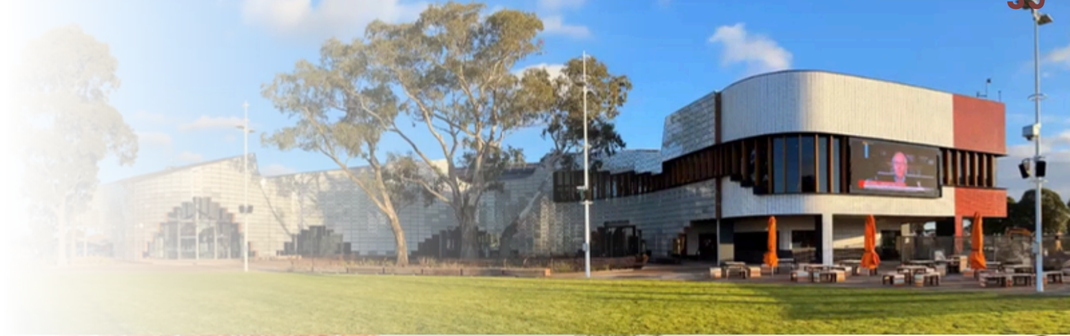
Figura 35 - Fachada Sul Springvale
