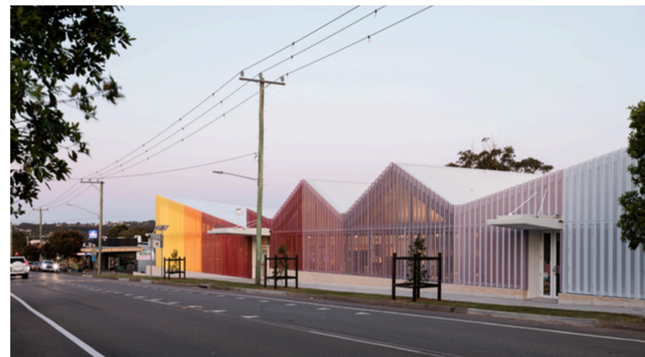
Figura 46 - Fachada frontal - Centro Comunitário Windale
