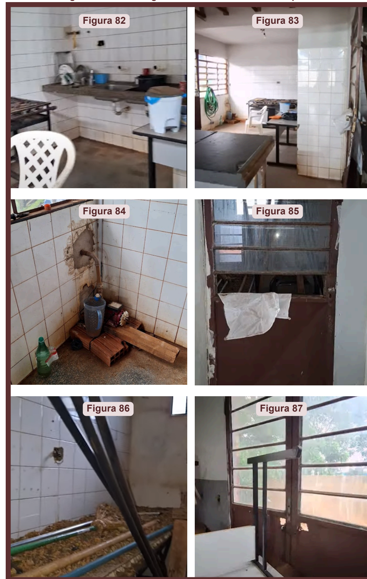
Figura 82 a 87 - Imagens internas da cozinha e depósito
