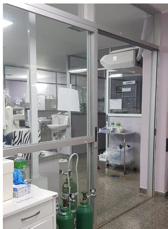
Figura 4 - Entrada da UTI-B
