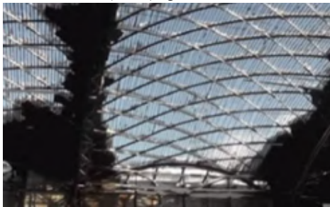
Figura 27 - Vyksa Steel Production Hall. Fonte: ARSENYEV (2011) apud I. SOUZA, 2019.
