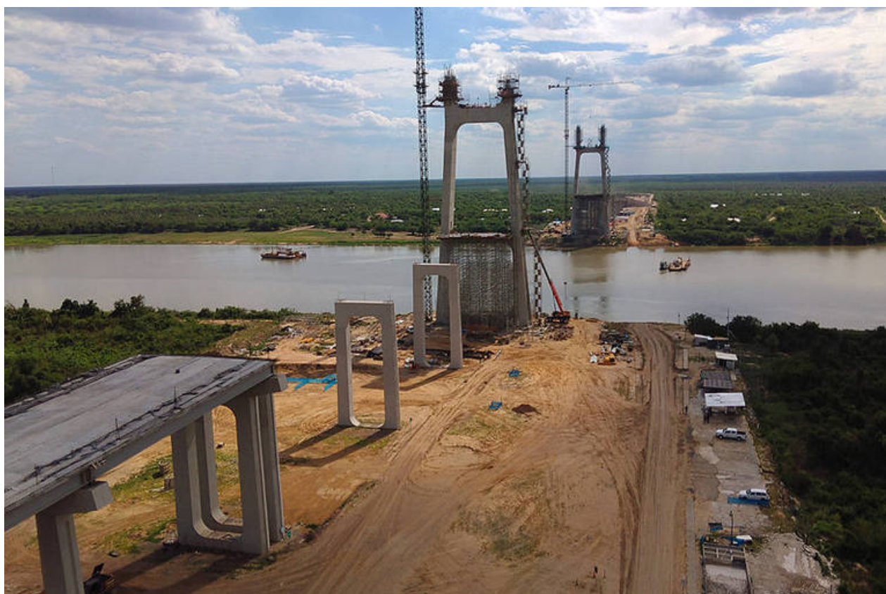
Construção da ponte Bioceânica no rio Paraguai, entre Porto Murtinho, em Mato Grosso do Sul, e Carmelo Peralta, no Paraguai - Álvaro Rezende/Secom MS
