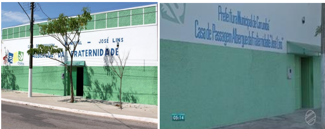
Figura 03 e 04: Fachada da Casa de Passagem “Albergue da Fraternidade”
