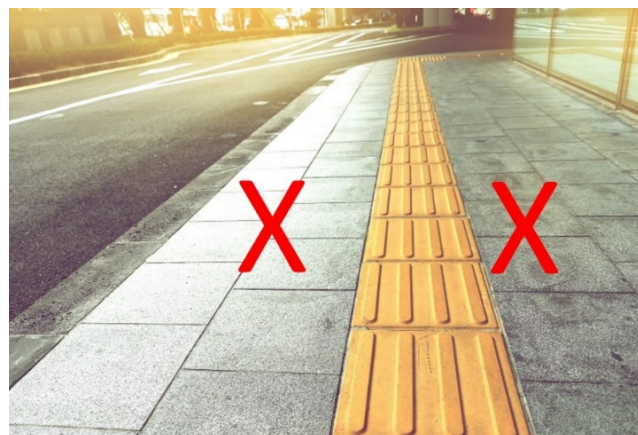
Figura 5 – Piso com junta ao lado da sinalização tátil direcional. Fonte: adaptado Eduardo Ronchetti Consultoria em Acessibilidade, 2024
