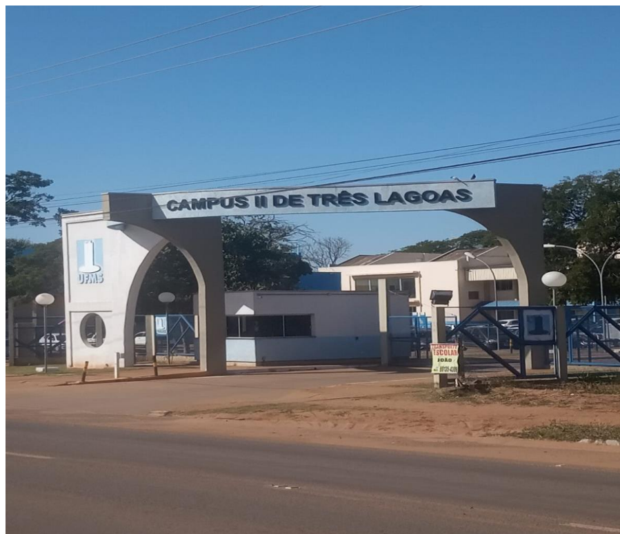
Figura 12: Fachada do CPTL-UFMS, Unidade II. Fonte: Acervo Próprio.
