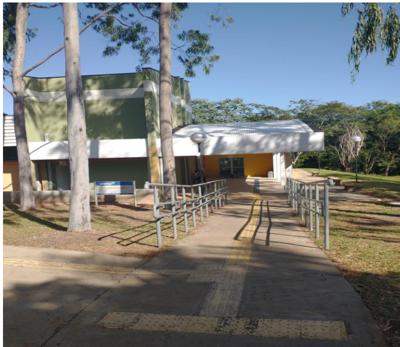
Figura 6: Fachada do RU da FCT/UNESP. Fonte: Acervo próprio.
