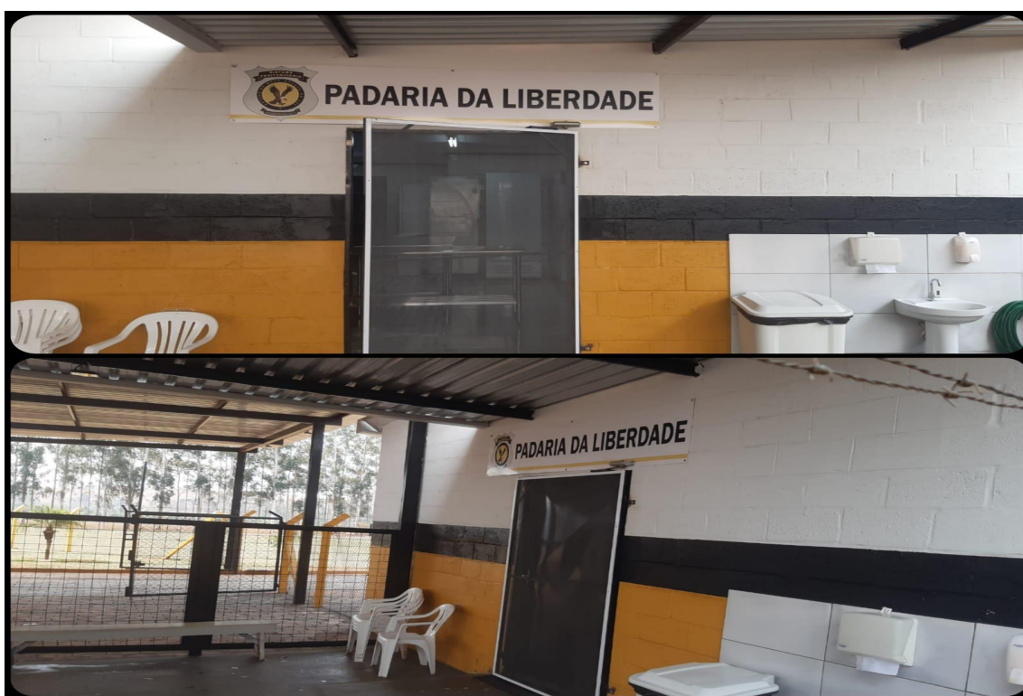
Figura 12 – Fachada da entrada da Padaria da Liberdade.
