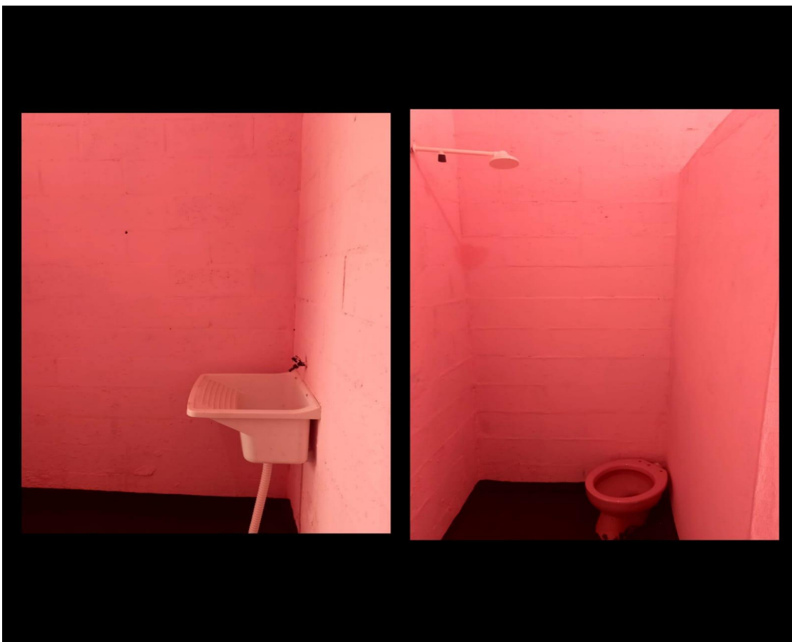
Figura 33 - Celas comunidade LGBT. Lavatório e Banheiro.
