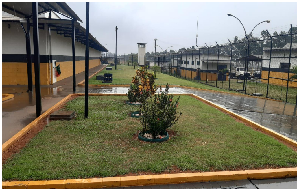
Figura 6 – Foto A - Espaço entre as celas e o Pavilhão Administrativo.
