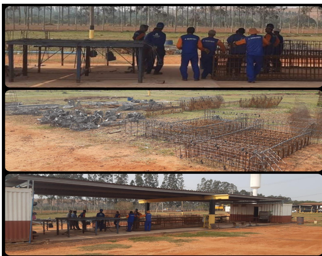
Figura 25 - Reeducandos Trabalhando na Montagem de ferragens.
