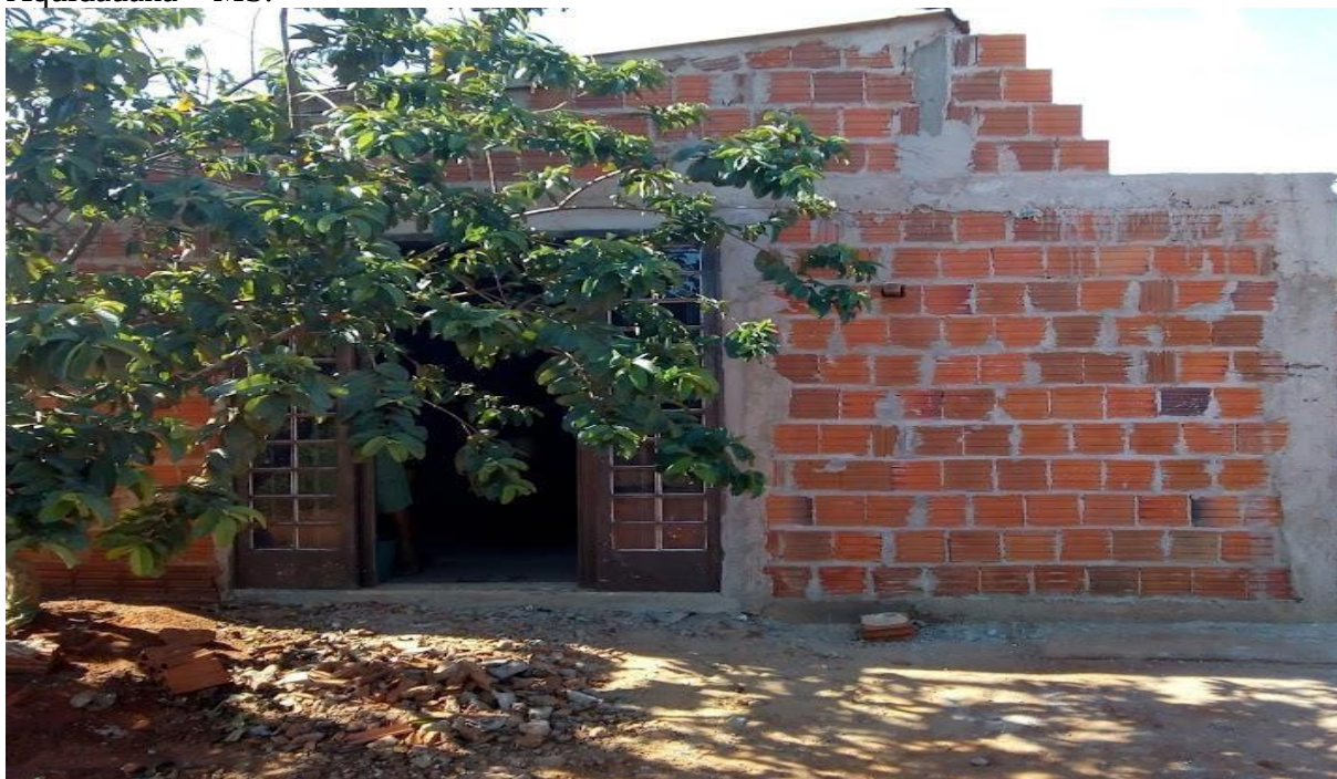
Figura 7 - Imóvel comercial inacabado presente na ocupação urbana Jardim São Francisco II, Aquidauana – MS.
