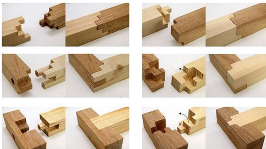
Figura 26 - Tipos de encaixe do sistema Tsugite
