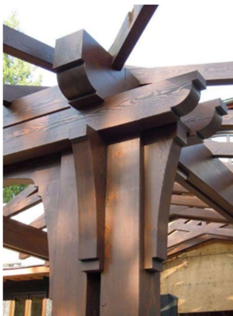
Figura 24 - Encaixes em estrutura de madeira
