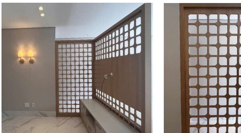
Figura 23 - MDF aplicado em painel de marcenaria, utilizando técnicas de marcenaria tradicional na caixaria com técnicas de fabricação digital nos elementos vazados, cortados à laser em uma CNC
