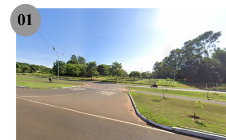
Figura 54 - Rua Salomão Abdala fonte: Google Street
