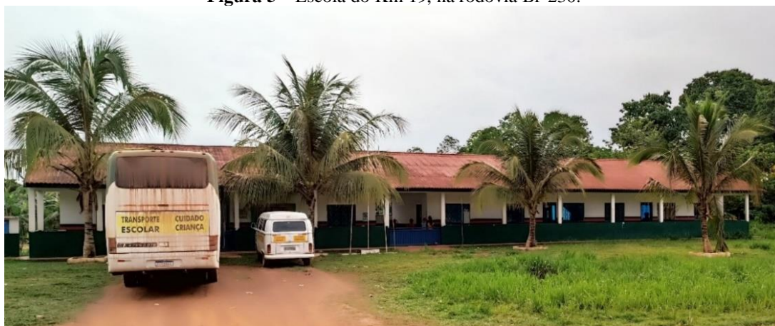
Figura 5 – Escola do Km 19, na rodovia Br-230.
