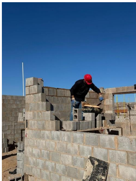
Figura 7 - Assentamento da argmassa (Fonte:Autorial; Data:17/07/2025)
