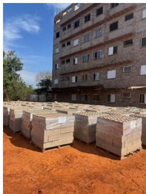
Figura 4 - Blocos armazenados ao lado da edificação (Fonte:Autoral; Data:17/07/2025)
