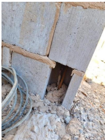
Figura 15 - Janela de Inspeção (Fonte: Autoral; Data: 17/07/2025)
