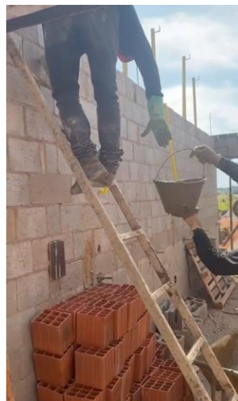
Figura 8 - Grauteamneto com balde (Fonte:Autorial; Data:17/07/2025)
