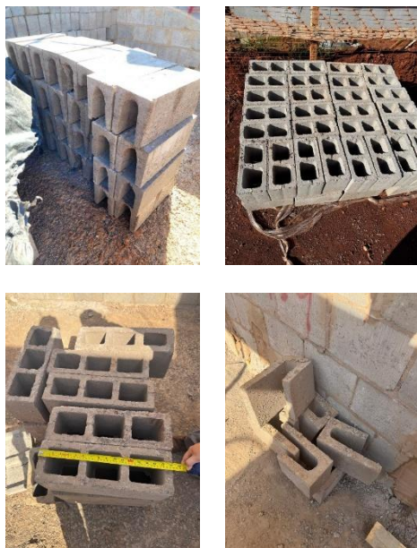
Figura 3 - Blocos Utilizados em Obra (Fonte:Autoral; Data:17/07/2025)
