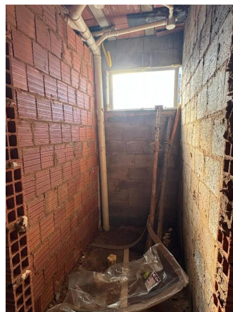
Figura 12 - Alvenaria de vedação (Fonte: Autoral; Data: 17/07/2025)
