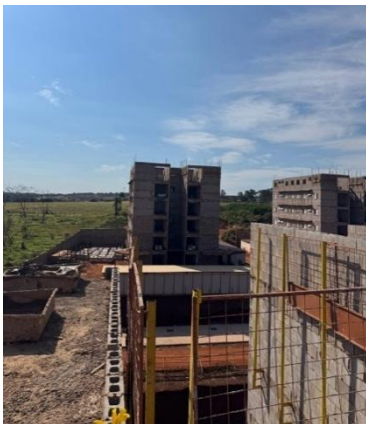
Figura 2 - Etapa atual da edificação (Fonte: Autoral; Data: 17/07/2025)
