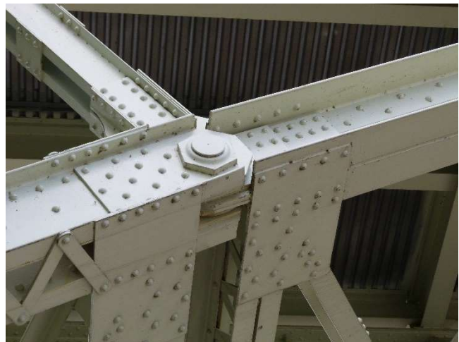
Figura 5 - Ligação flexível e ligação rígida com chapa Gousset . Fonte: Holth, e McOmber.
