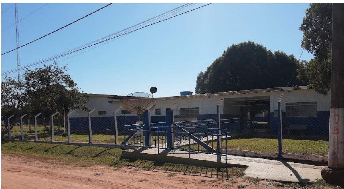
Figura 28 - Escola Municipal Ada Moreira Barros - Distrito de Cipolândia
