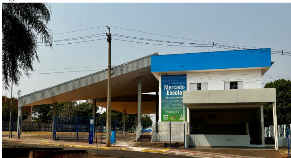
Figura 7 - Obras do Mercado Escola - UFMS
