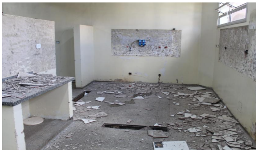
Figura 9 - Reforma do Restaurante Universitário da UFGD
