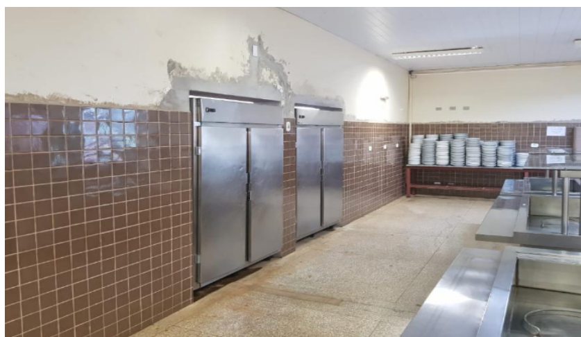
Figura 10 - Reforma do Restaurante Universitário da UFGD
