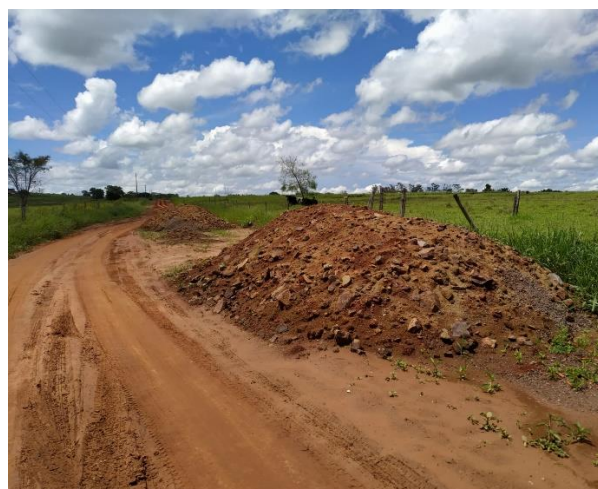
Figura 18- Assentamento Arizona/Andradina (SP) - Estrada Interna após chuvas 2
