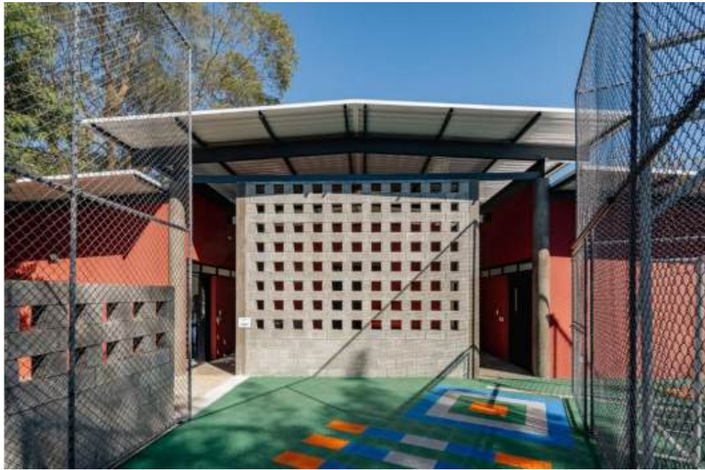
Figura 35 - Paredes de tijolos reaproveitados no Centro Santa Marta.
