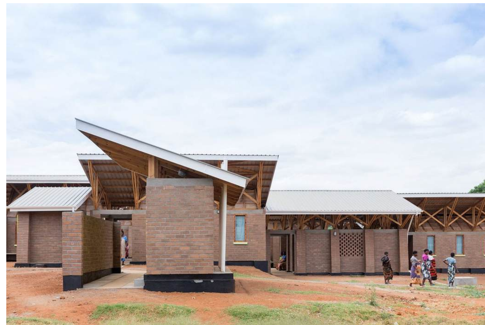
Figura 46 – Fachada e estrutura do Centro para Gestantes.
