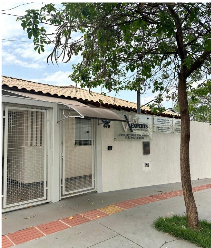
Figura 1. Fachada Vet Experts. Fonte: Arquivo pessoal.
