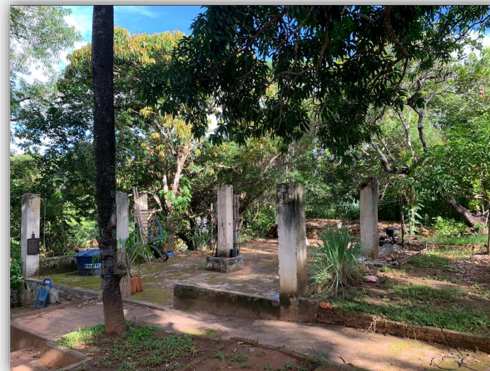
Figura 29 - Área pavimentada e resquícios de pilares da antiga edificação demolida
