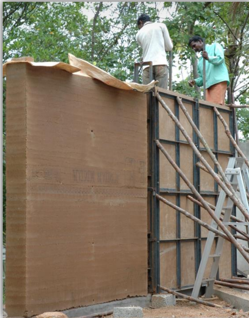
Figura 40- Parede de Taipa de Pilão
