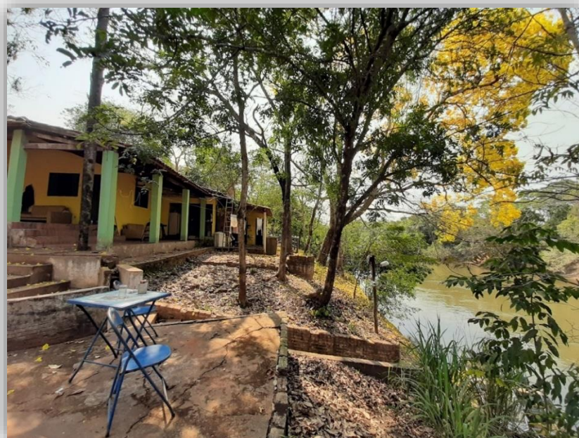
Figura 27 - Proximidade da Construção com o Rio Aquidauana
