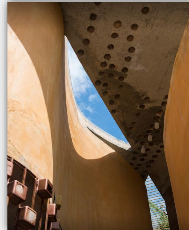
Figura 41- vista das fibras de coco presente na concretagem da cobertura
