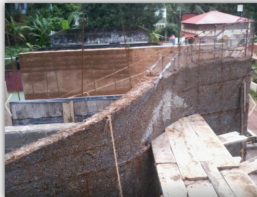
Figura 37- Parede curva feita com entulho de construção anterior e terra
