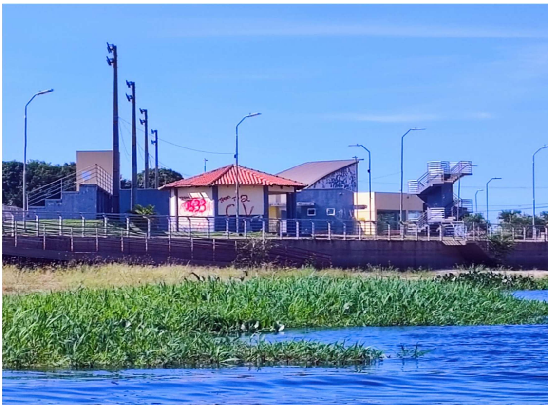
Imagem 1 - Estrutura portuária de Vila Bela da Santíssima Trindade – MT, com pixação de demarcação de ORCRIM.
