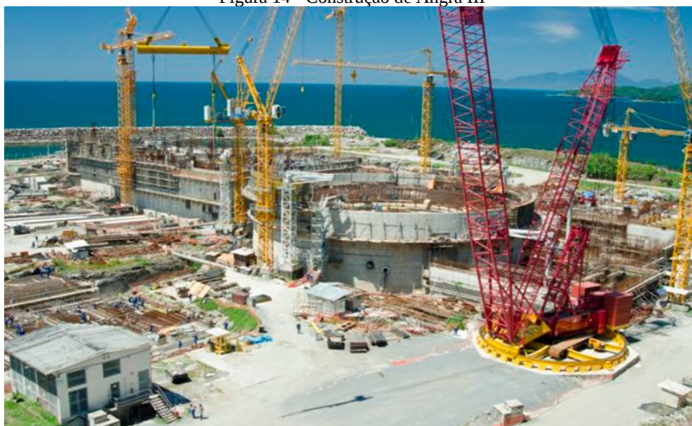
Figura 14 - Construção de Angra III
