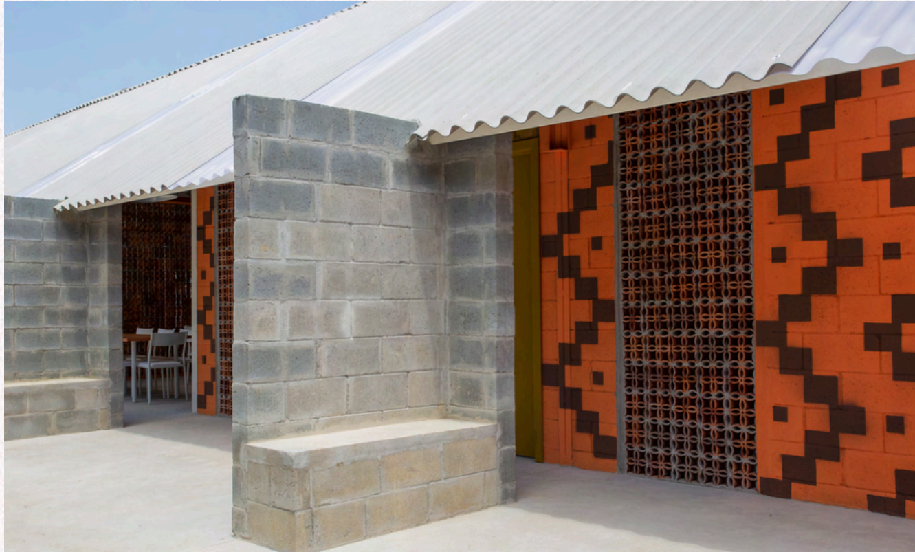
Figura 36 - Pinturas nas paredes Fonte: Tadu Arquitetura/João Duayer, 2022
