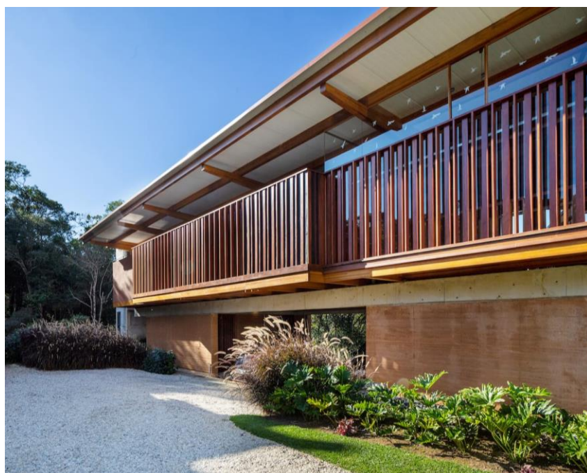
Figura 1 – Exemplo de construção contemporânea com taipa. Fonte: Taipal (2024)
