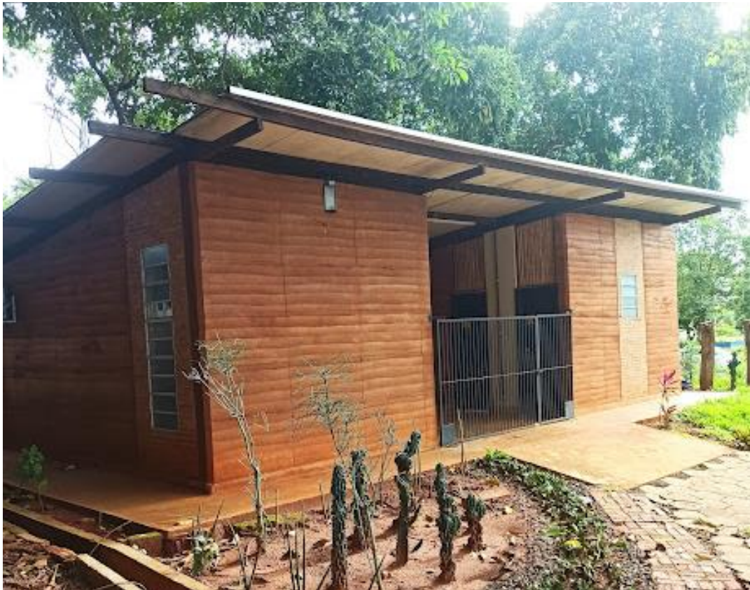
Figura 8 – Foto da fachada norte do Canteiro Experimental UFMS. Fonte: Autoral
