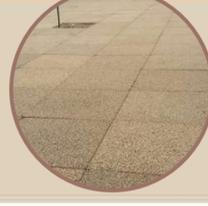
Piso Fulget: piso drenante a base de concreto e pedrisco. Áreas de passagem e permanência.
