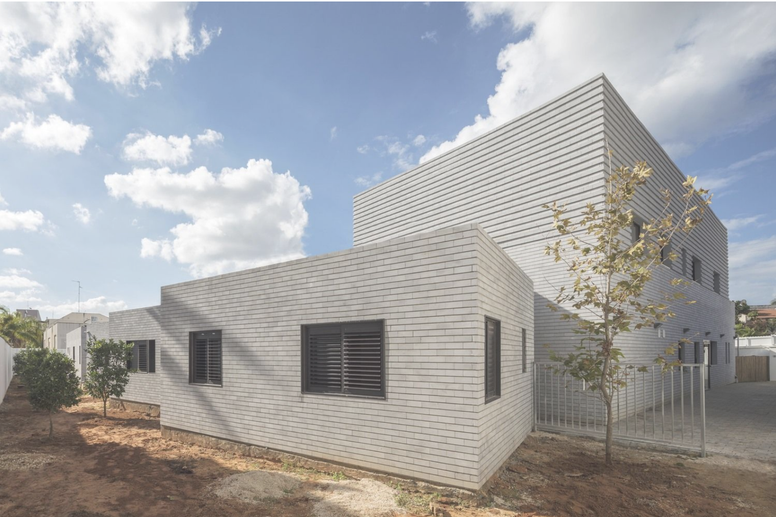
Figura 16: Área externa do Abrigo para Vítimas de Violência Doméstica / Amos Goldreich Architecture + Jacobs Yaniv Architects Fonte: Archdaily, 2018.
