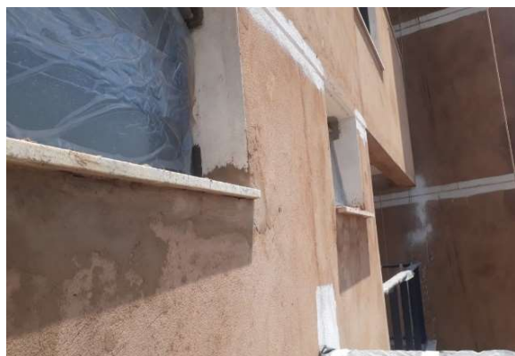
Figura 3 – Exemplos de revestimento externo e chapisco.
