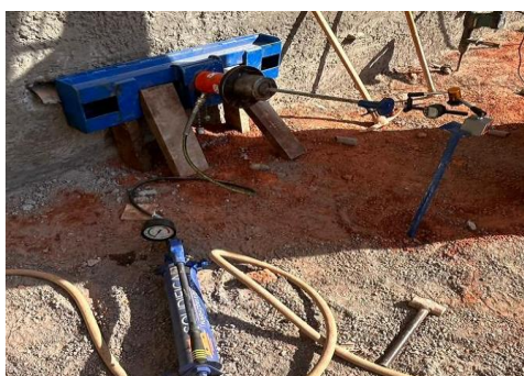
Figura 11 – Montagem do sistema para os ensaios de arrancamento.
