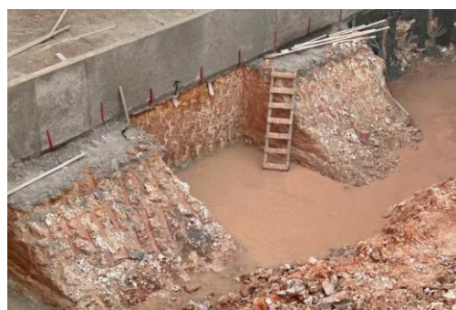
Figura 4 – Abertura de nichos
