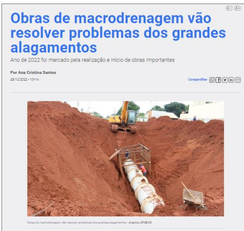
Figura 11 – Reportagem sobre obras de Macrodrainagem Fonte: Site RCN67 (2022)
