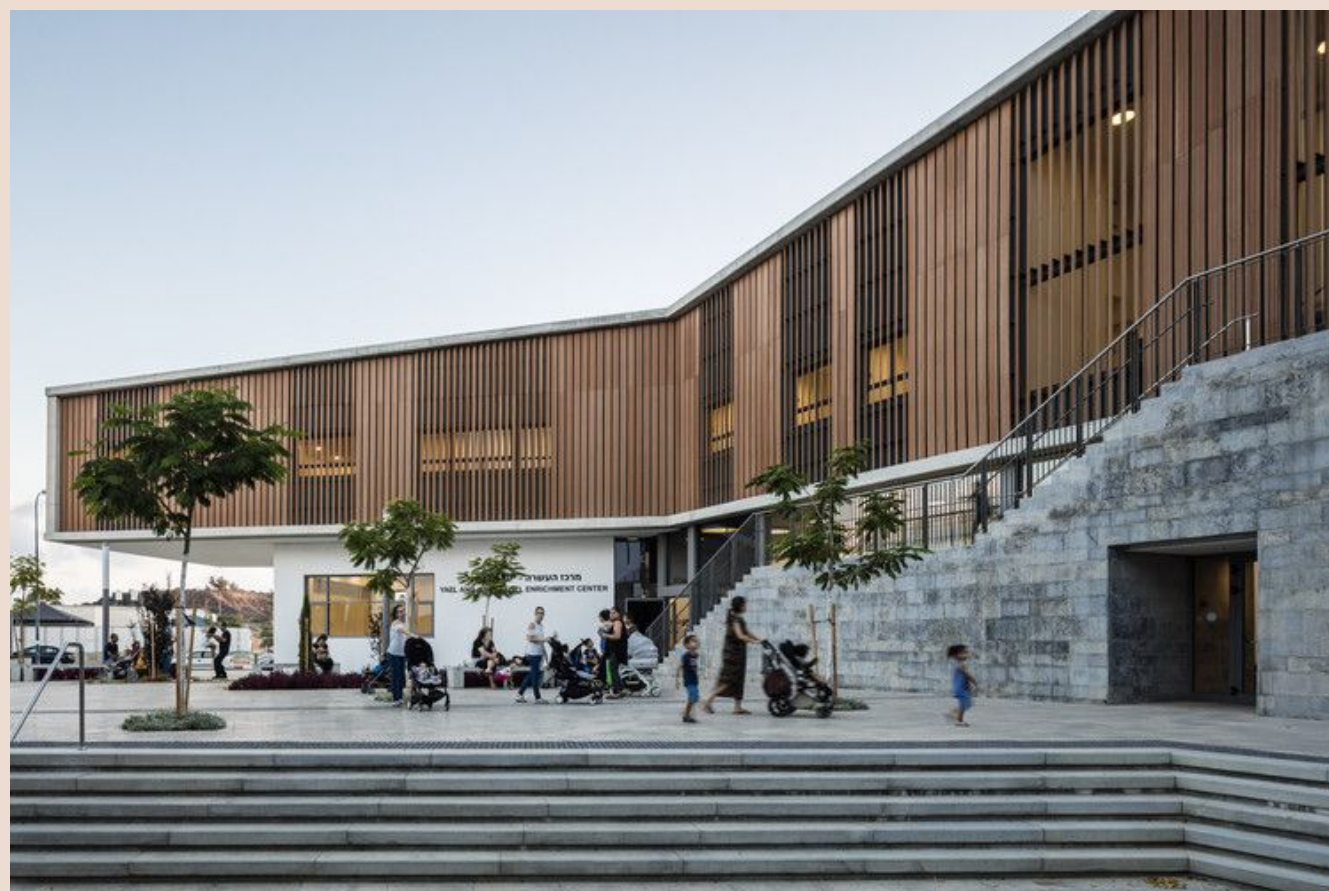
Figura 10 - Centro Comunitário Rehovot
