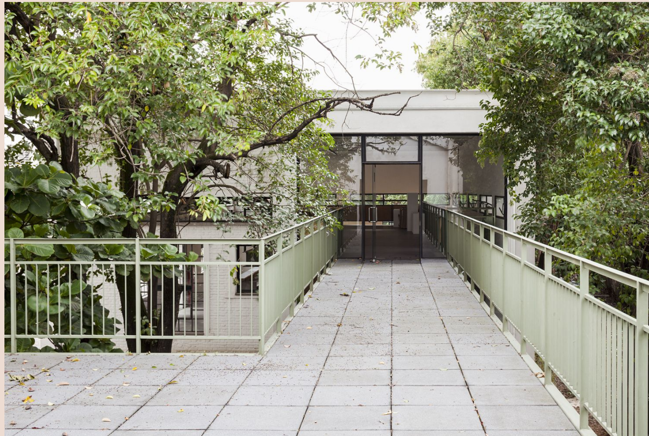
Figura 21 - Mezanino entre dois edifícios
