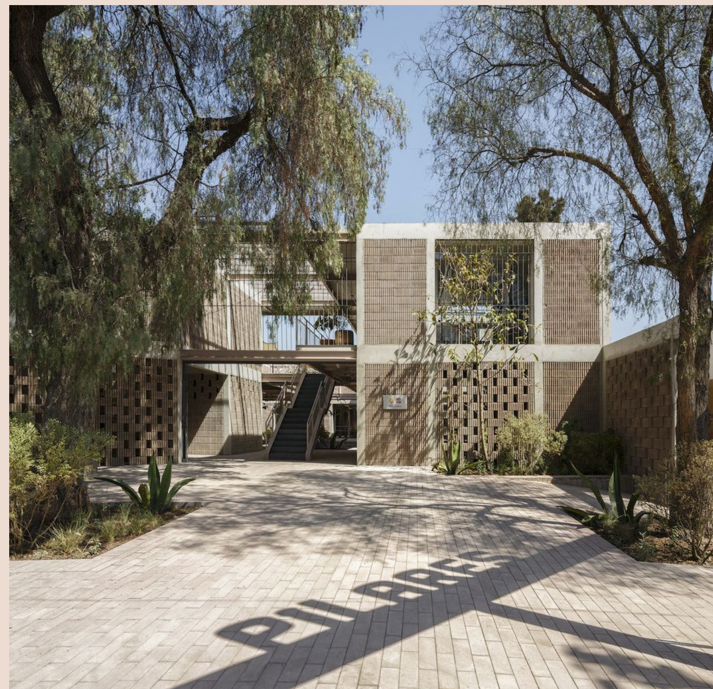
Figura 14 - Fachada Centro Cultural Pilares
