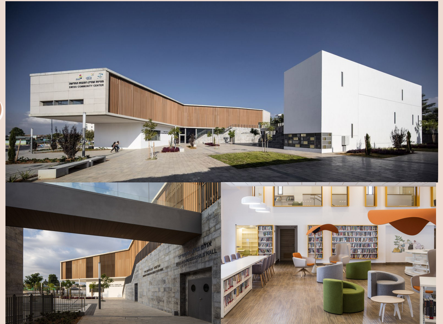
Figura 11 - Vistas Centro Comunitário Rehovot
