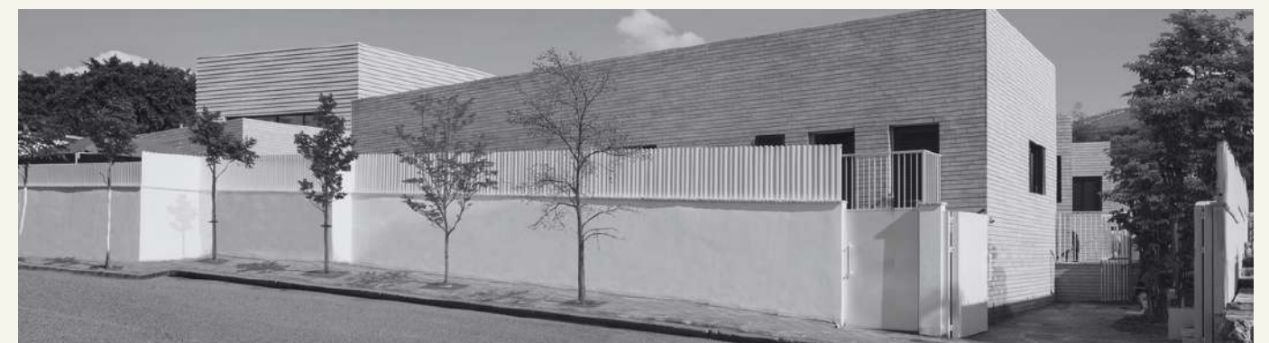
Figura 12: Fachada do edifício No to the Violence Shelter. Fonte: Archdaily, 2015. Adaptado pela autora, 2025.
