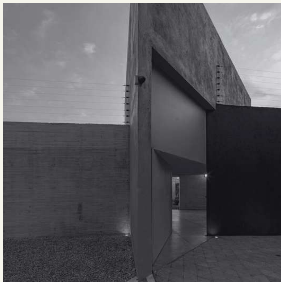
Figura 22: Fachada do edifício Refugio Origen. Fonte: Archdaily, 2018. Adaptado pela autora, 2025.
