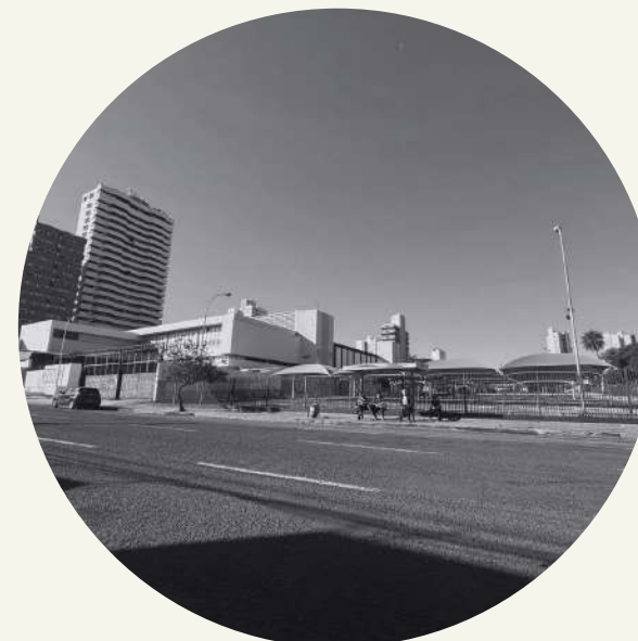
Figura 46: Fotografia da situação atual do terreno escolhido. Fonte: Acervo pessoal da autora, 2025.
