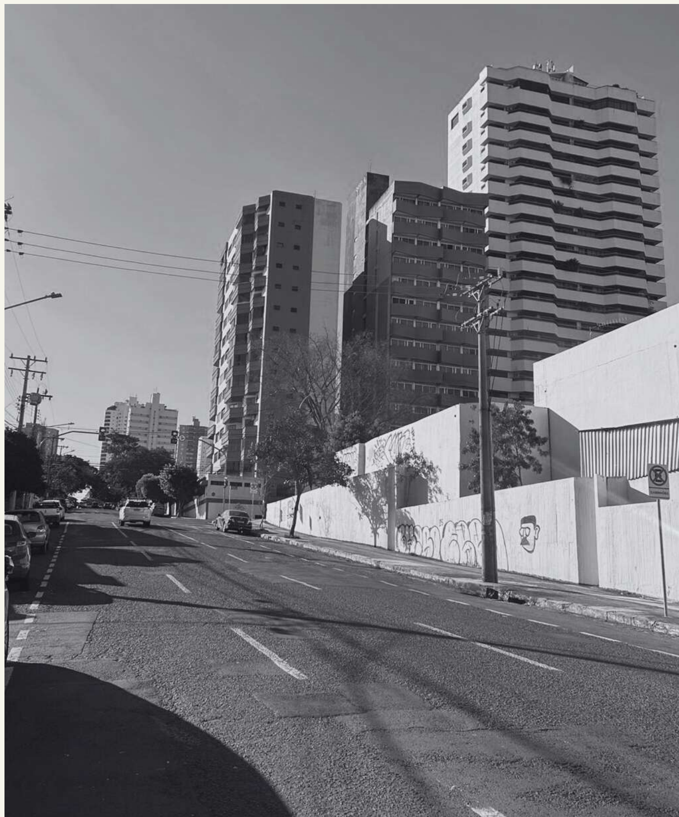
Figura 45: Fotografia da situação atual do terreno escolhido. Fonte: Acervo pessoal da autora, 2025.
