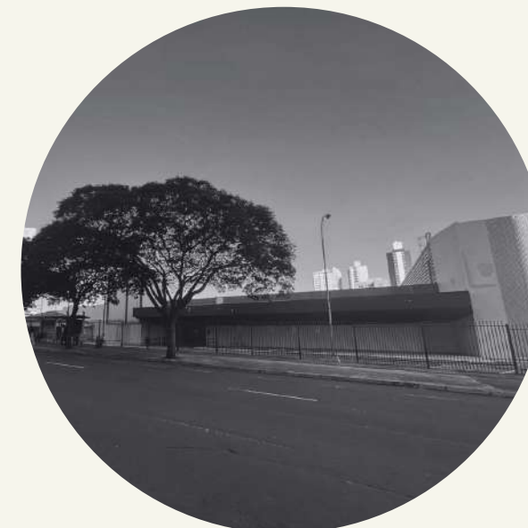
Figura 47: Fotografia da situação atual do terreno escolhido. Fonte: Acervo pessoal da autora, 2025.
