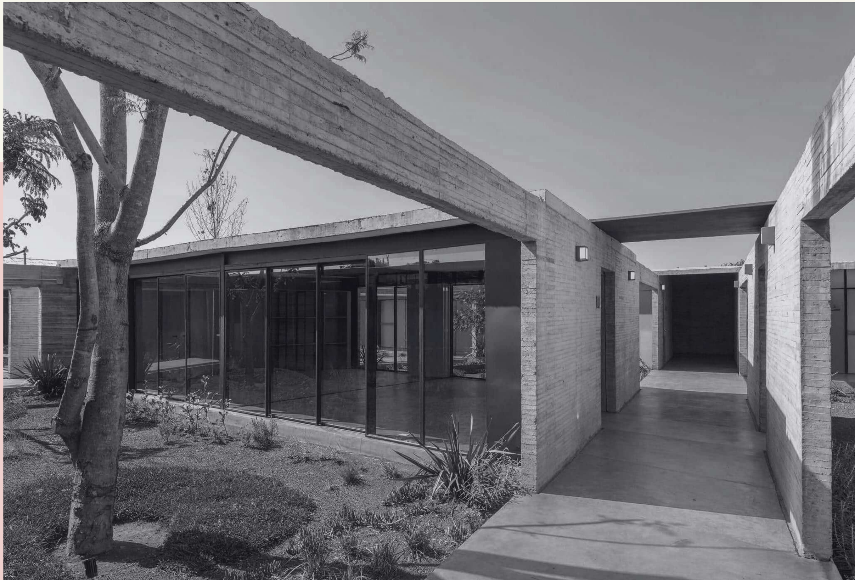
Figura 21: Corredores externos do edifício Refugio Origen. Fonte: Archdaily, 2018. Adaptado pela autora, 2025.
