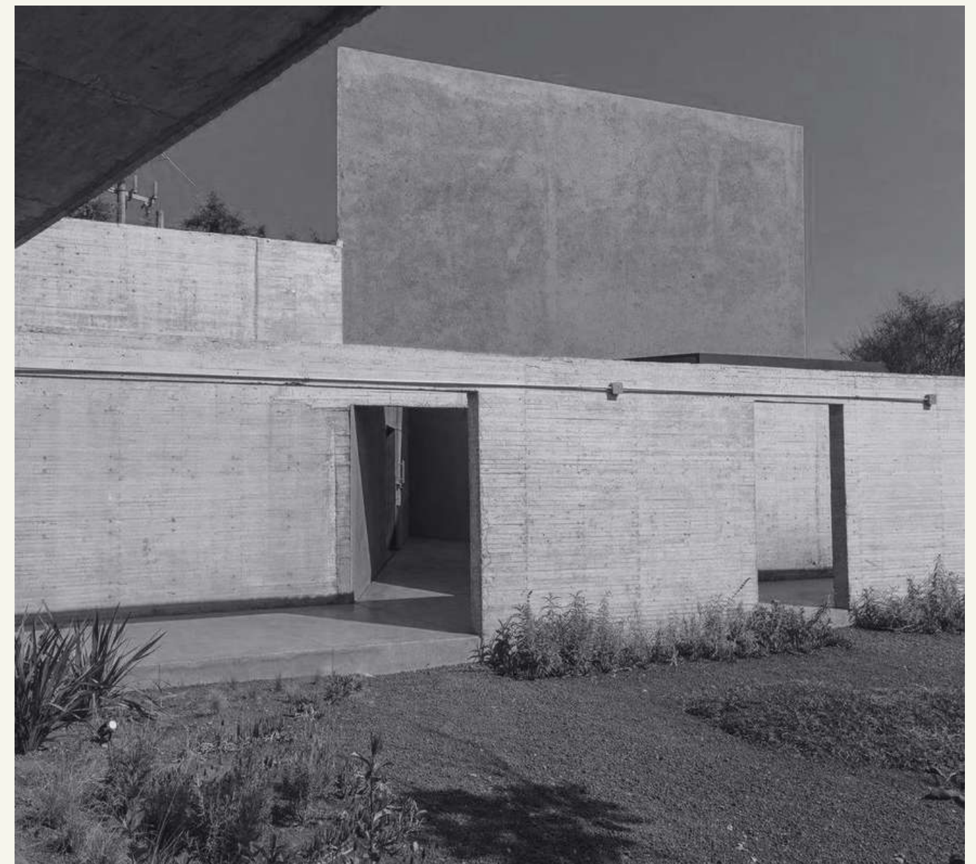
Figura 19: Fachada do edifício Refugio Origen. Fonte: Archdaily, 2018. Adaptado pela autora, 2025.
