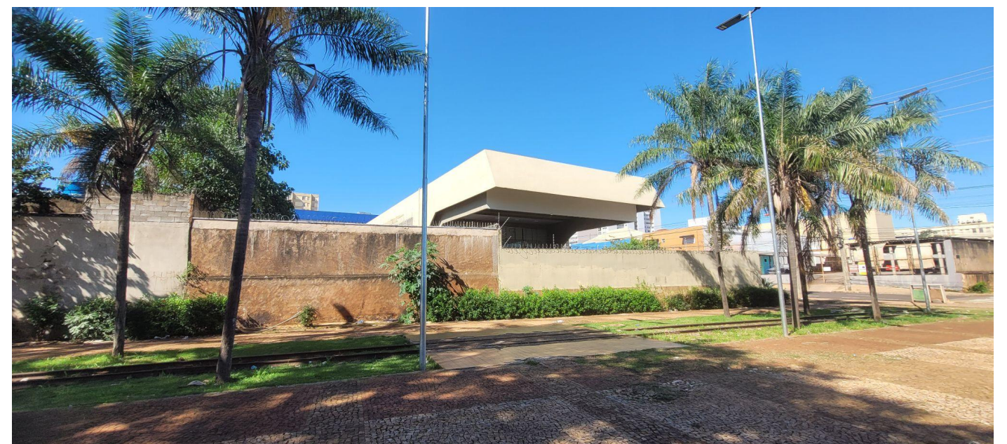
Figura 112 - Fundo do lote onde será proposto o pocket park, ao lado da Energisa.
