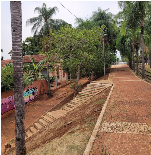
Figura 51 - Escadaria da Orla para rua Antônio Maria Coelho.
