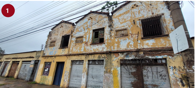
Figura 67 - Imóveis abandonados Av. Calógeras
