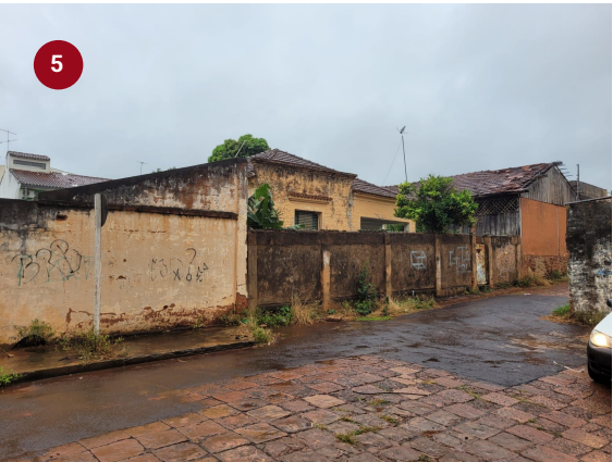
Figura 97: Imóveis abandonados na Tv. Pimentel. Fonte: Acervo pessoal, 2025.
