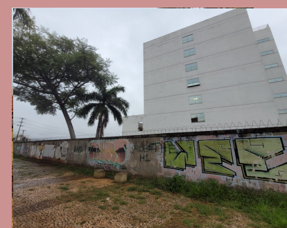
Figura 60 - Muro do hospital
