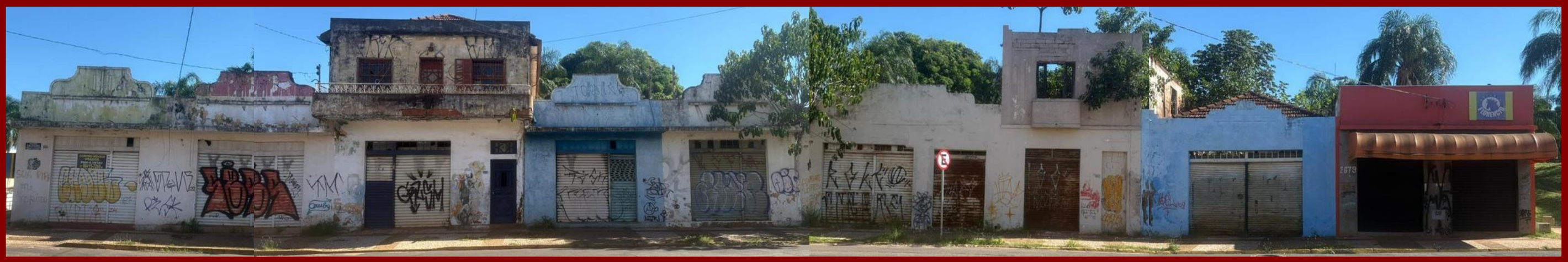
Figura 106 - Condições atuais das fachadas da Av. Calógeras
