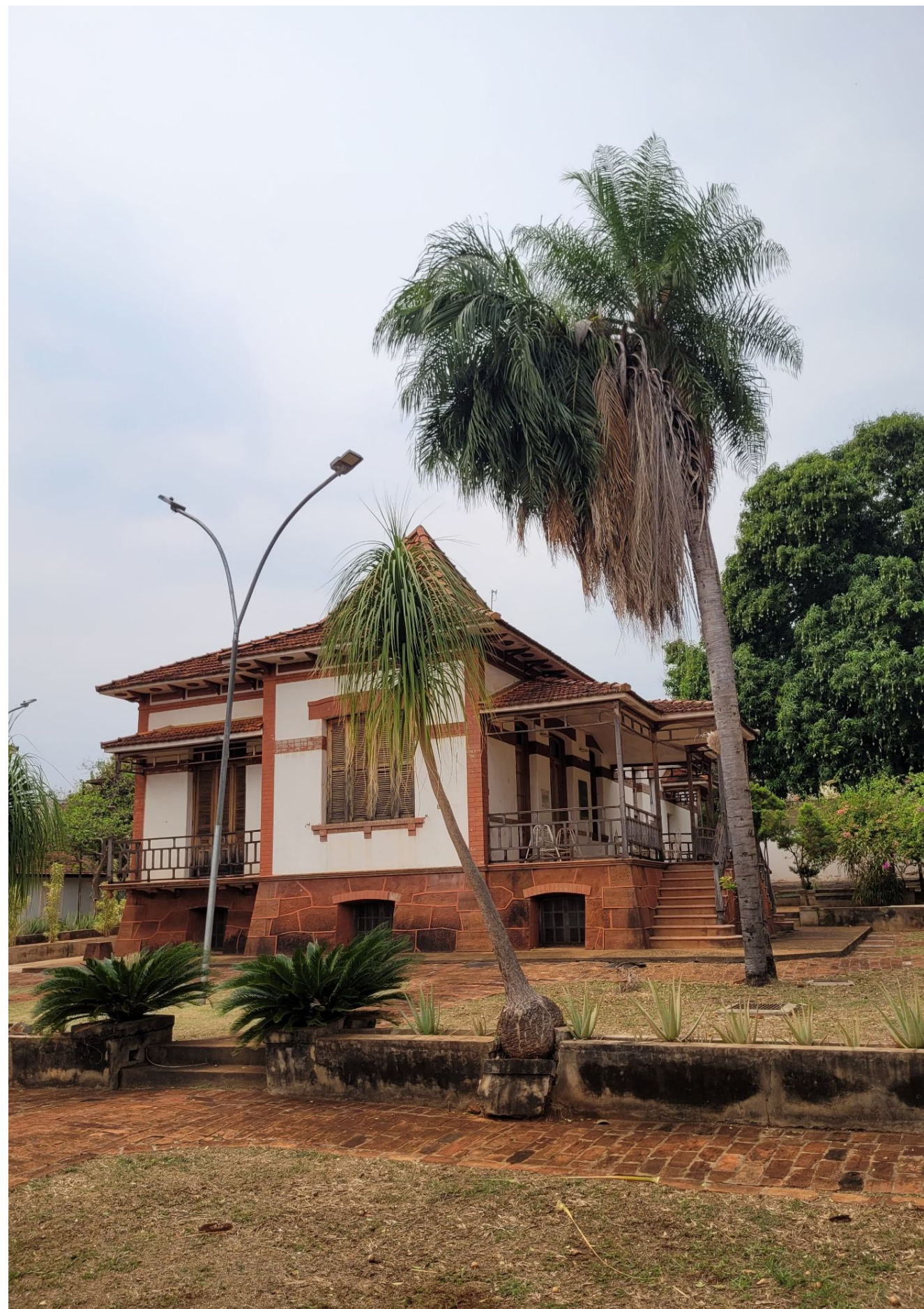
Figura 39 - Casa do chefe da NOB: fachada R. dos ferroviários.
