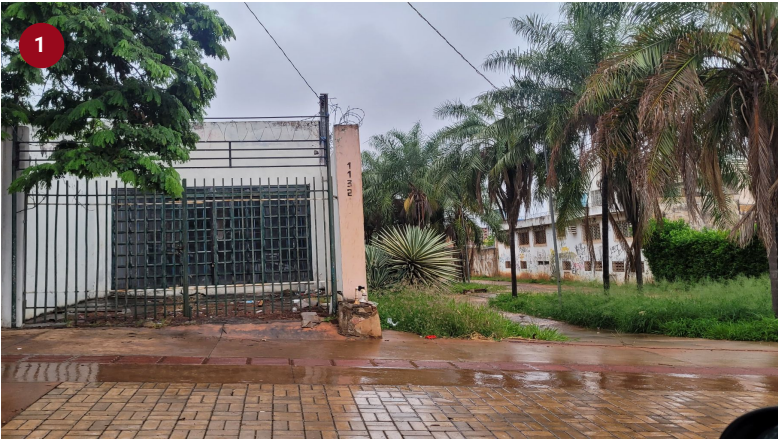
Figura 88: Imóvel abandonado na esquina da rua Dom Aquino Fonte: Acervo pessoal, 2025.
