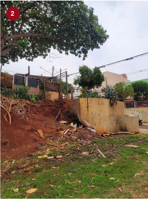
Figura 89: Área degradada perto da rua Barão do Rio Branco Fonte: Acervo pessoal, 2025.
