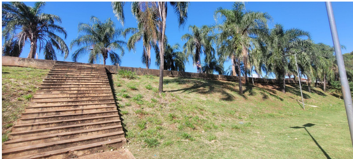
Figura 17: Escadaria que acessa a parte interna da quadra.
