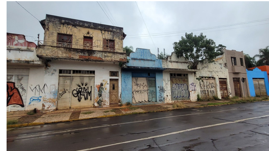
Figura 44 - Conjunto de edifícios tombados na Avenida Calógeras
