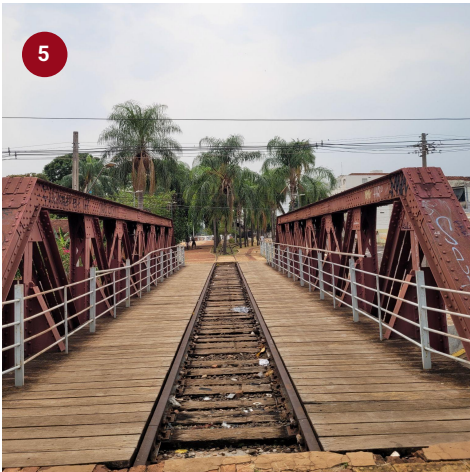
Figura 66 - Pontilhão sobre a rua Antônio Maria Coelho
