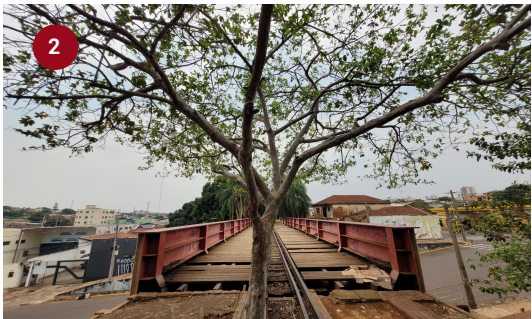
Figura 78 -- Pontilhão sobre a rua Maracaju
