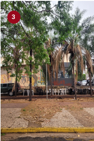
Figura 95: Calçamento degradado. Fonte: Acervo pessoal, 2025.
