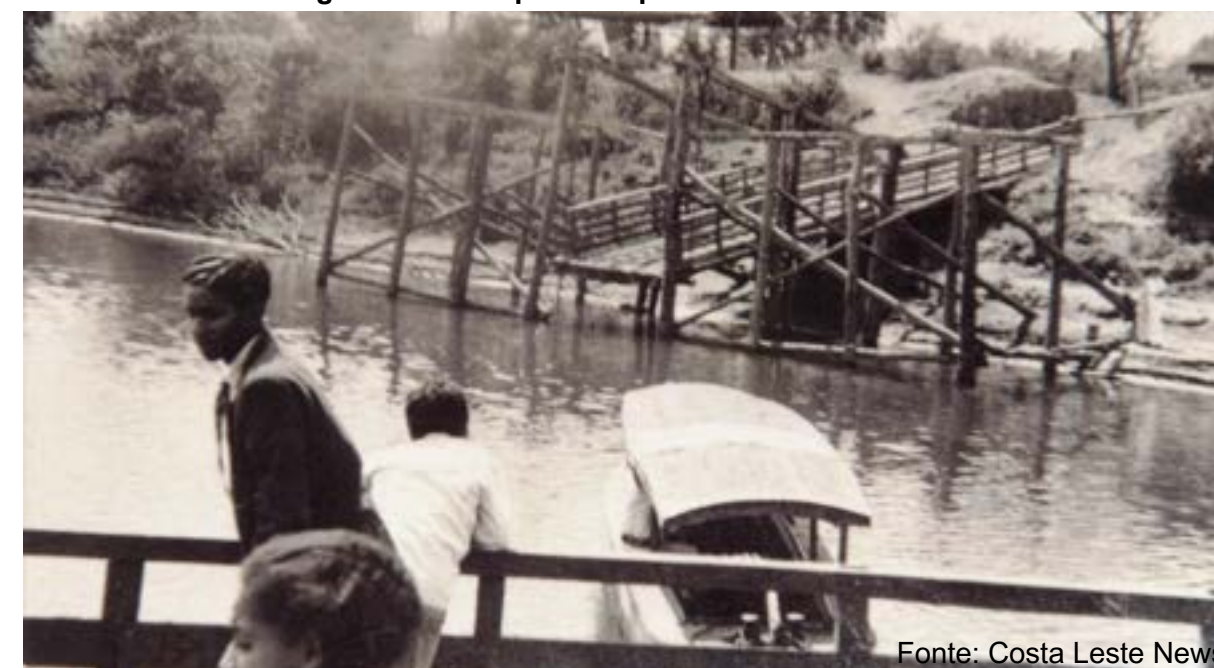
imagem 01: Transporte de pessoas através da balsa
