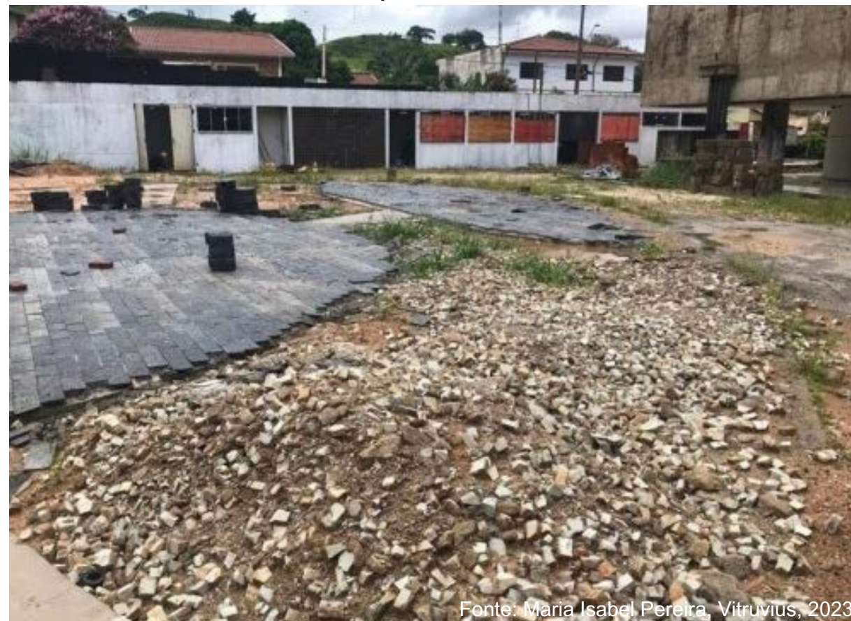
Imagem 04: Remoção das pedras portuguesas do piso e dos cobogós nas paredes
