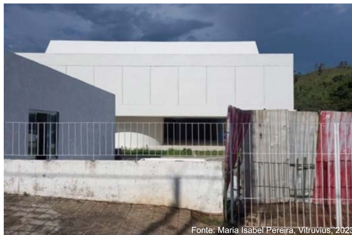
Imagem 03: Balneário de Águas da Prata, pintura em branco do concreto armado aparente.
